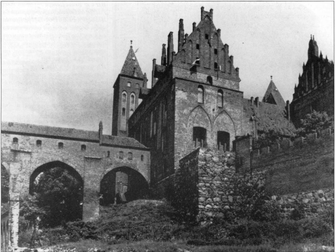
Замок и укрепленный мост к нечистой башне, Мариенвердер (Квидзын), Польша. Построен тевтонским орденом в 1233 г.
