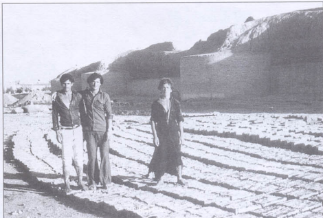
Стена Рака из саманного кирпича, возведена в 772 году. Снаружи саман выложен особым слоем обожженного кирпича, а фундамент из известняка.
