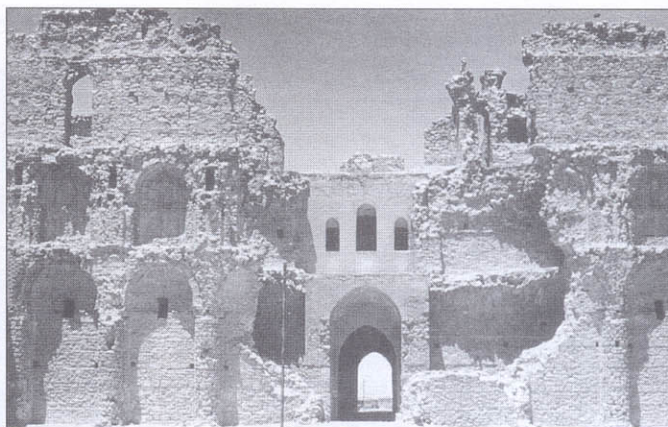
Укрепления Ухайдир в Ираке. Постройка достаточно сложная. С четырех сторон имеются ворота, казематы на верху стены, крытые галереи представляют собой машикули.
