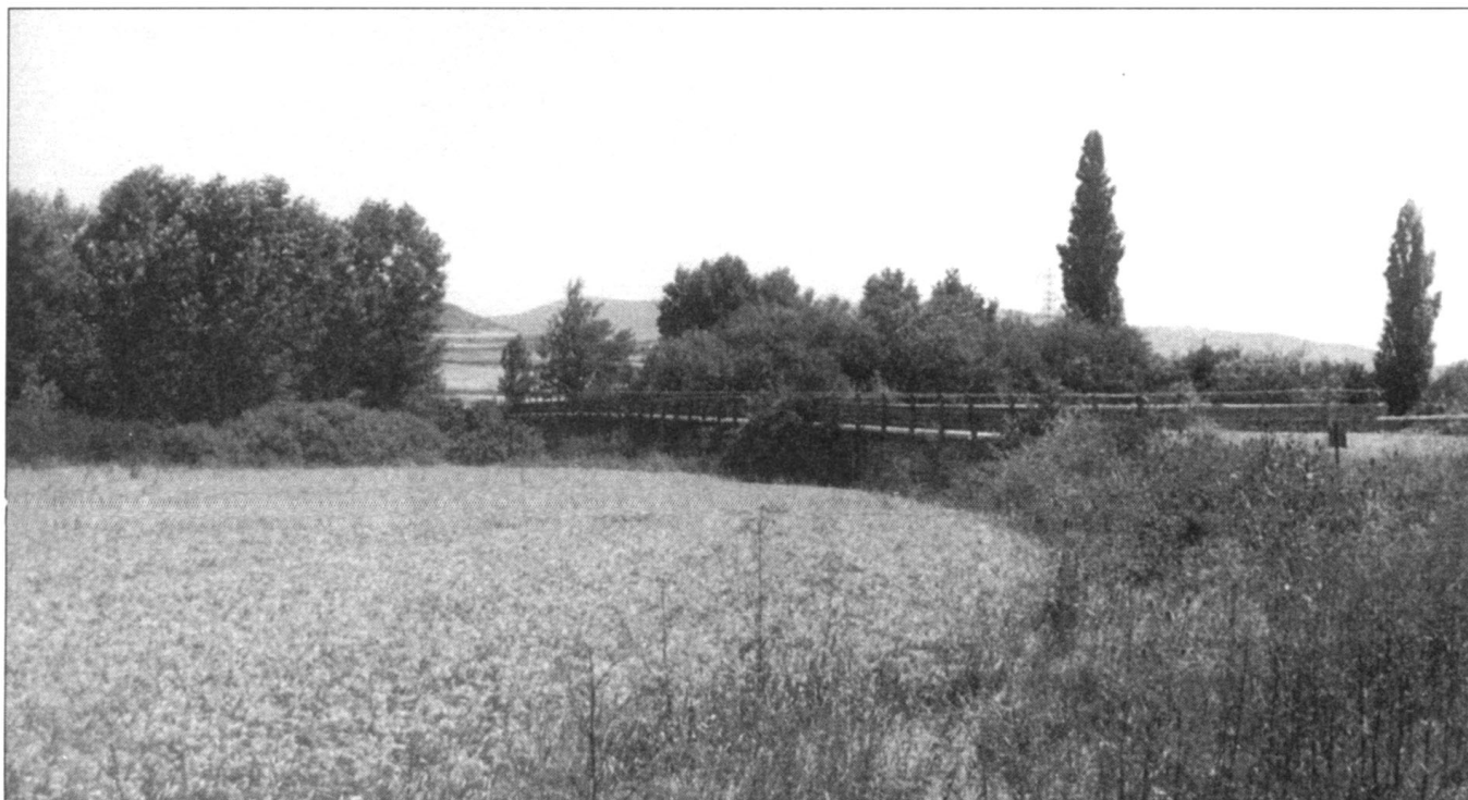
Мост через реку Садорра у Мендосы, по которому переправлялась 3-я дивизия Пиктона. Этот мост подвергся коренной реконструкции, хотя в нем осталось несколько первоначальных опор. Солдаты Пиктона переходили по нему справа налево. Слева вдали, за деревьями, виден холм Ариньез.
