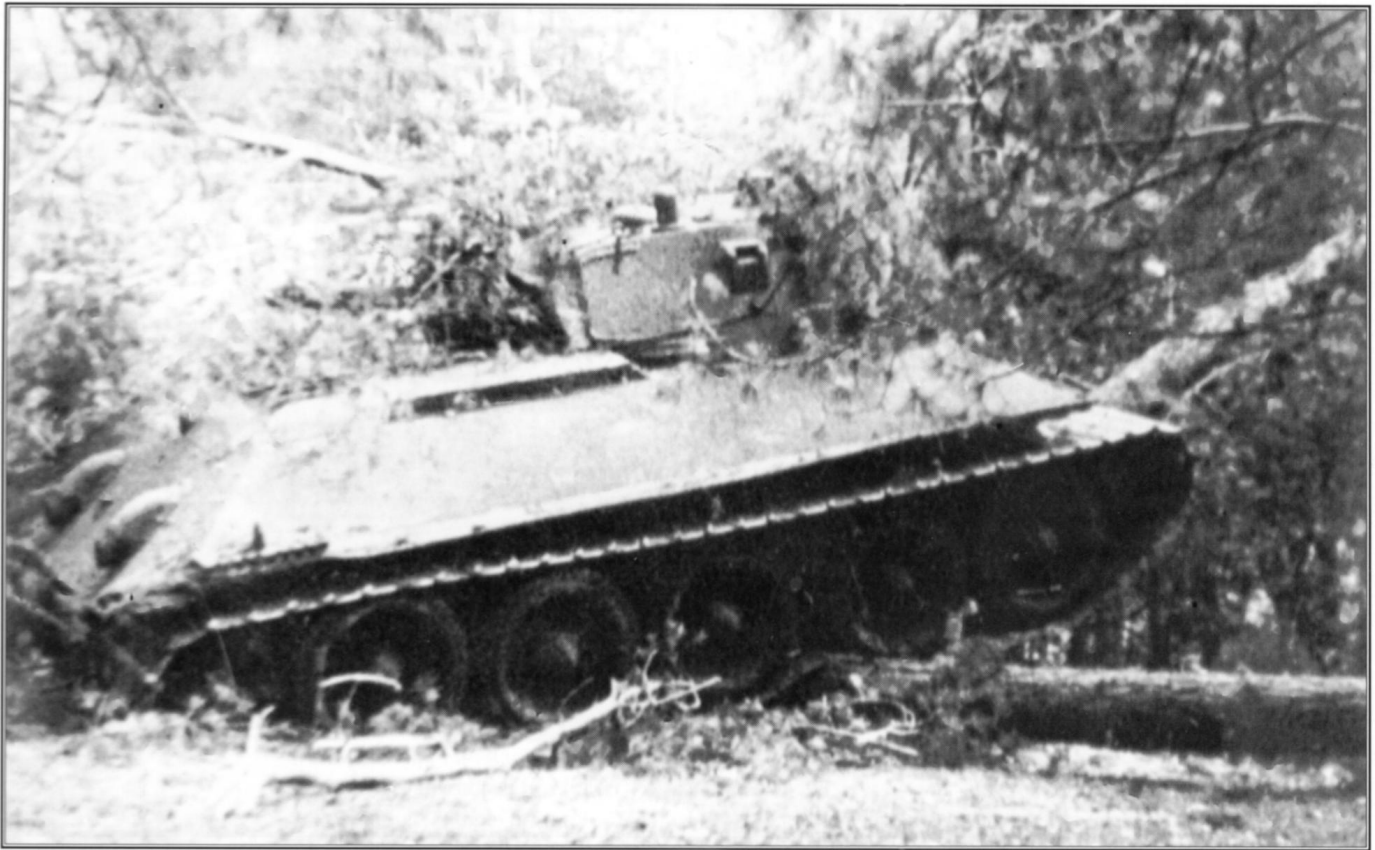
Prototyp czołgu A-34 nr 2 w czasie prób wojskowych, 1940 rok. Przejazd przez las sosnowy (średnica drzew 250-460 mm).
